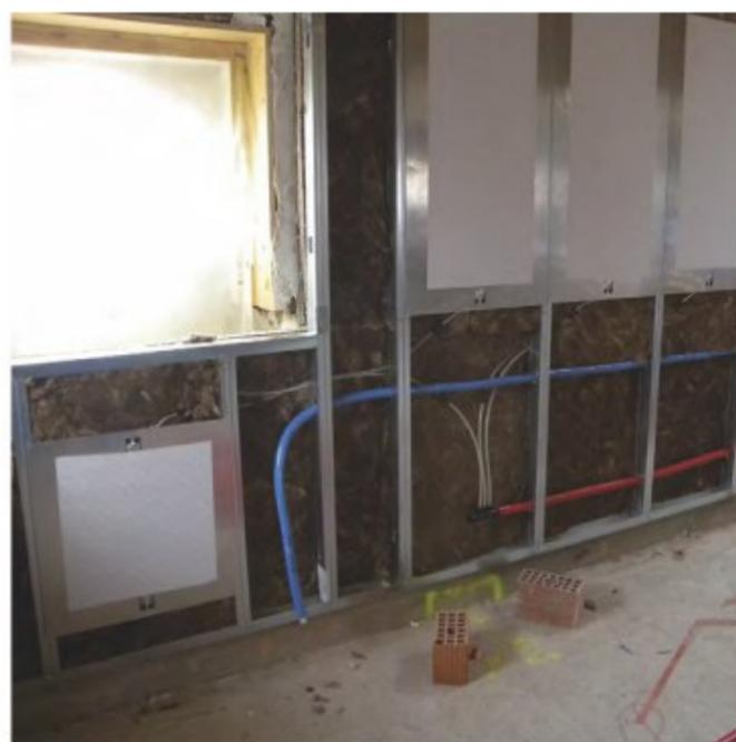
**IL SISTEMA** è estremamente versatile e permette la posa delle piastre radianti in alluminio nelle posizioni più efficaci a garantire le migliori condizioni di comfort, evitando sovrapposizioni con gli altri apparati impiantistici.
