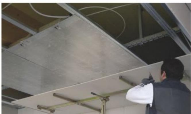
**IL CONTROSOFFITTO** al piano terreno durante la posa delle lastre di cartongesso: per l'installazione delle piastre radianti si sfruttano le stesse sottostrutture impiegate per i rivestimenti interni.
